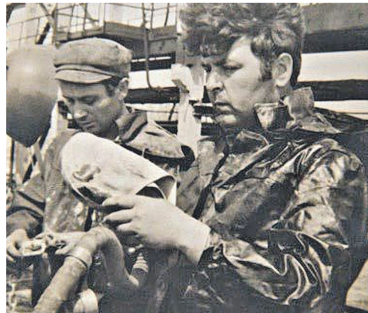
Иосиф Душанек на строительстве ПК «Шесхарис».
